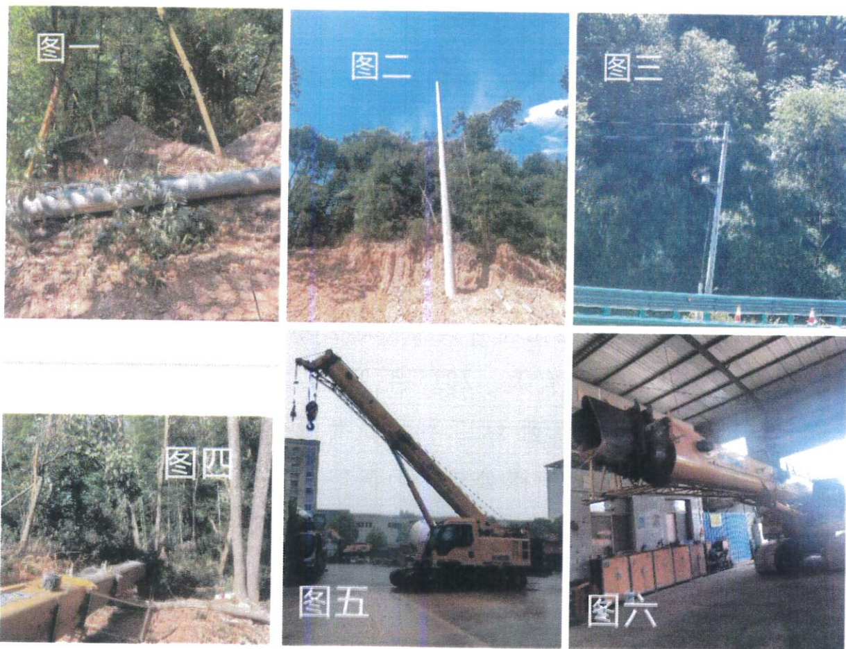
图一，吊车吊运材料；图二7月11日吊车作业吊运水泥电线杆；图三，10KV线路T结点；图四，吊车侧翻图；图五，吊车整体图；图六，吊车修理中的图片
